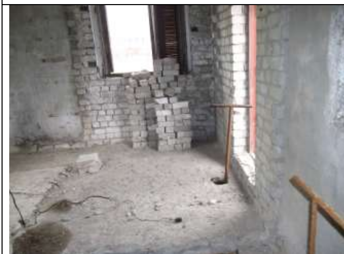
Фото 9.1.9 Неопломбированный вороток пере-пусковой задвижки на очистных в пос.Прибрежный
