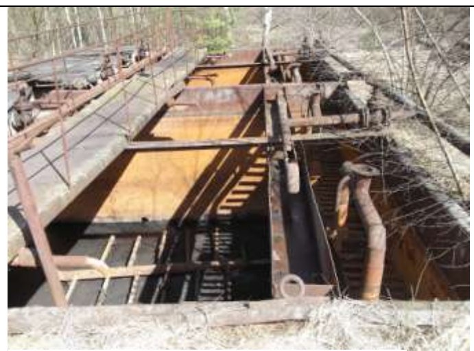
Фото 9.1.4 Аэротенки на ОСК в с. Сущёво
