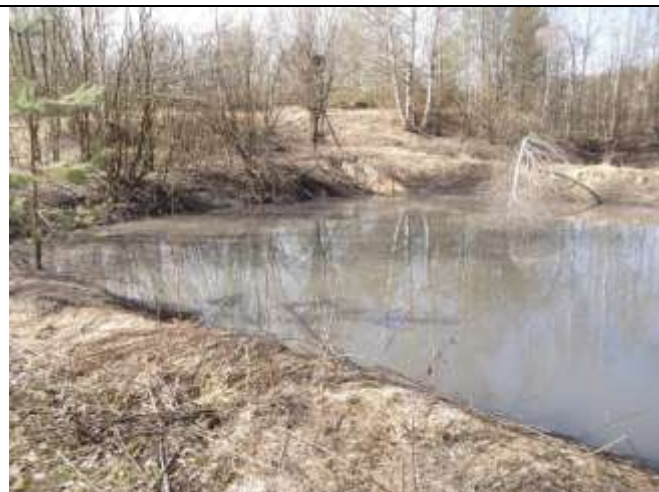
Фото 9.1.6 Один из двух водоёмов доочистки на ОСК в с. Сущёво, выполняет роль основного отстойного водоёма
