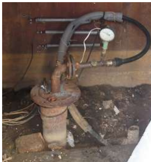
Фото 1.4.2 Внутреннее расположение скважины в постройке д. Крутик
