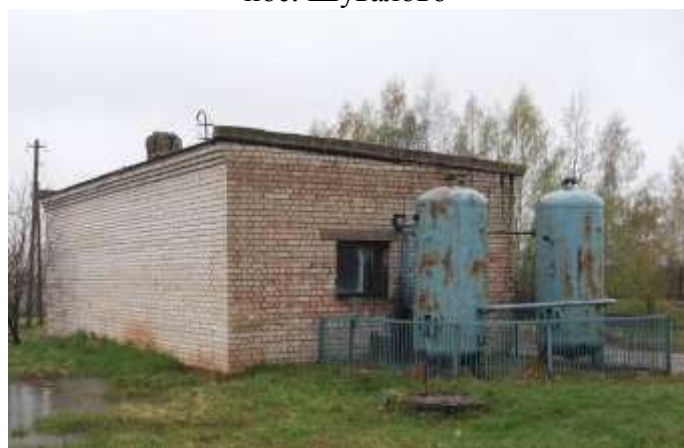
Фото 1.4.22 Строение станции обезжелезивания пос. Шувалово
