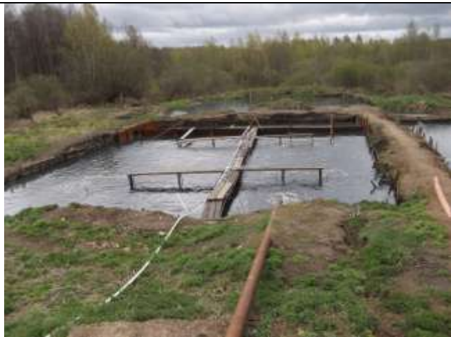
Фото 9.1.11 Пруд доочистки на ОСК пос. Прибрежный
