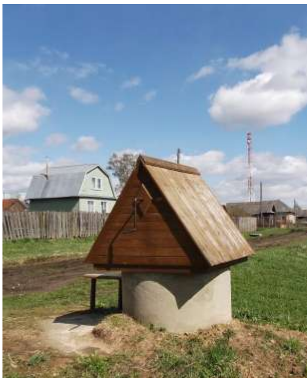
Фото 1.2.3 Новый уличный водоразборный колодец в д. Болтаново
