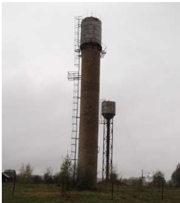
Фото 1.4.19 Водонапорные башни пос. Шувалово
