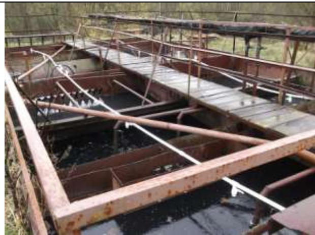
Фото 9.1.14 Аэротенки без аэрации в пос. Шувалово
