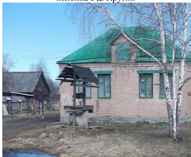
Фото 1.4.6 Резервный водоразборный уличный колодец в д. Крутик
