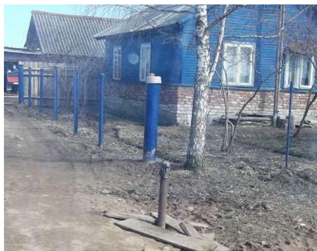
Фото 1.4.4 Резервная уличная водоразборная колонка в д. Крутик
