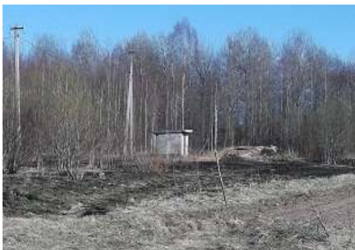
Фото 1.4.3 Постройка скважины № 2 и подземный кессон скважины № 3 в д. Крутик
