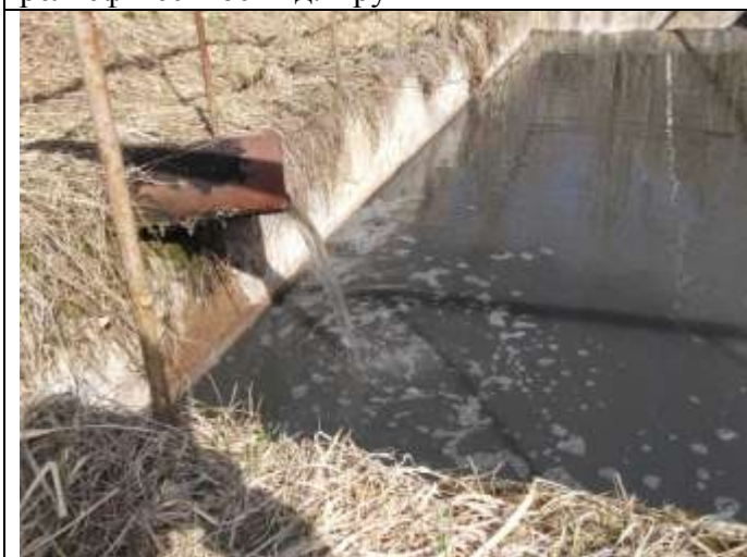
Фото 9.1.3 Ёмкость-отстойник на ОСК в с. Сущёво
