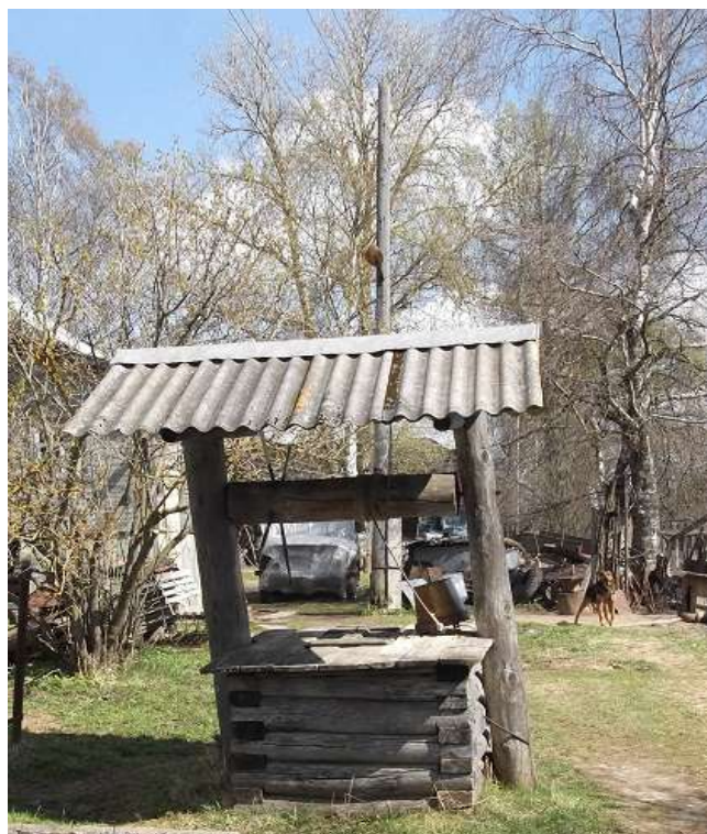
Фото 1.2.4 Старый уличный водоразборный колодец
