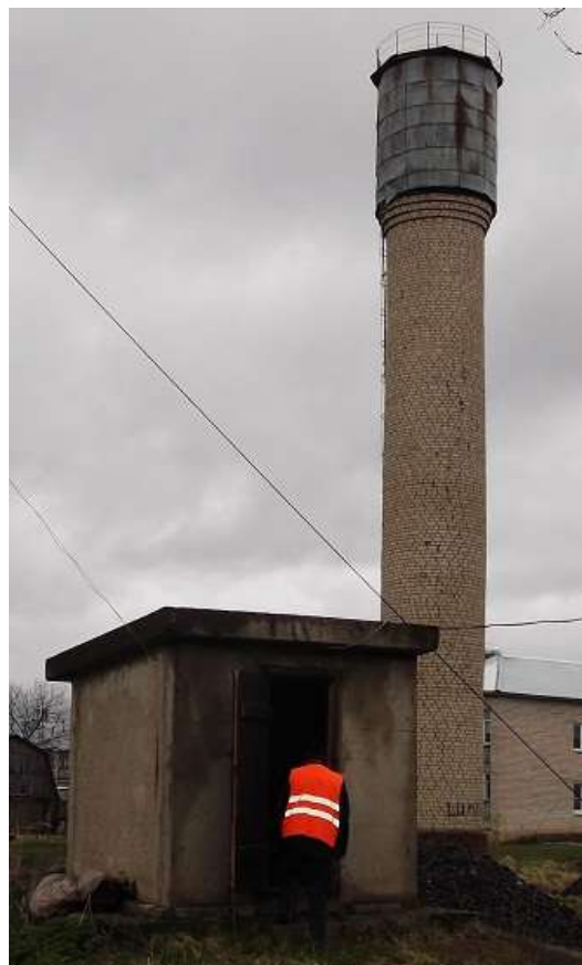
Фото 1.4.8 Скважина №2 и водонапорная башня пос. Прибрежный
