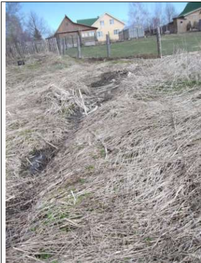
Фото 9.1.1 Перелив из колодца канализации на рельеф местности д. Крутик
