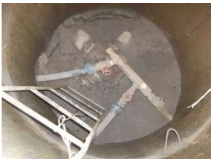
Фото 1.4.17 Кольцевание двух скважин в одном колодце смотровом в с. Сущёво
