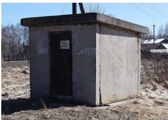
Фото 1.4.15 Строение артезианской скважины №1229 с. Сущёво
