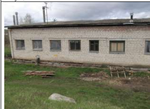
Фото 9.1.7 Здание ОСК в пос. Прибрежный
