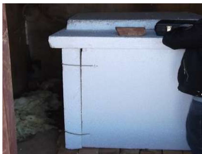
Фото 1.4.16 Способ утепления скважины №1229 с. Сущёво
