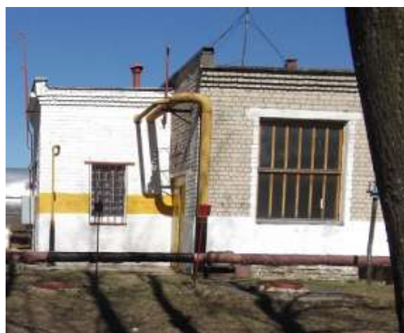
Фото 1.4.12 Котельная ГВС с. Сущёво
