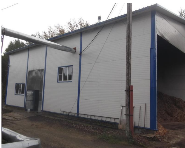
Рисунок 1.2.5 – Здание котельной в п. Прибрежный
