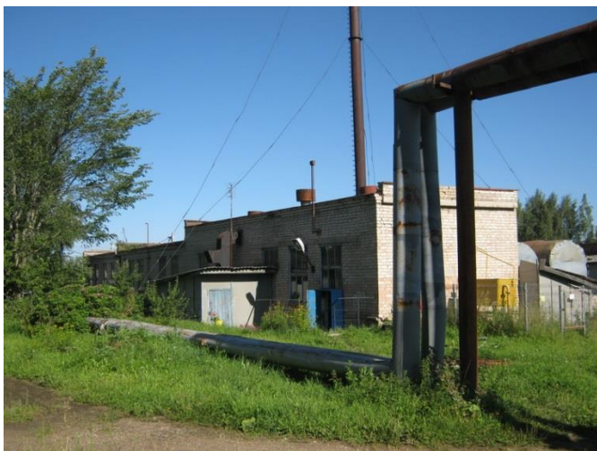
Рисунок 1.2.1 – Здание котельной и тепловая сеть в п. Шувалово
