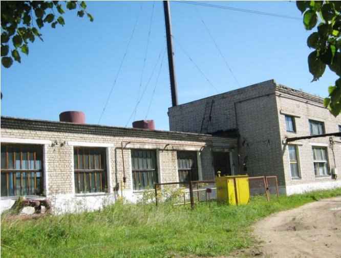
Рисунок 1.2.7 – Здание котельной в с. Сушево
