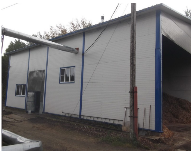
Рисунок 1.2.5 – Здание котельной в п. Прибрежный
