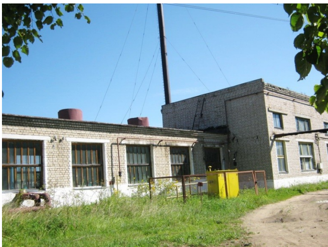
Рисунок 1.2.7 – Здание котельной в с. Сущево
