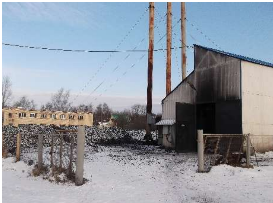
Фото 1.2.3.1 - Здание котельной п. Прибрежный
