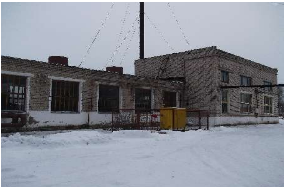
Рис.1.2.1.1 – Котельная с. Сущево
